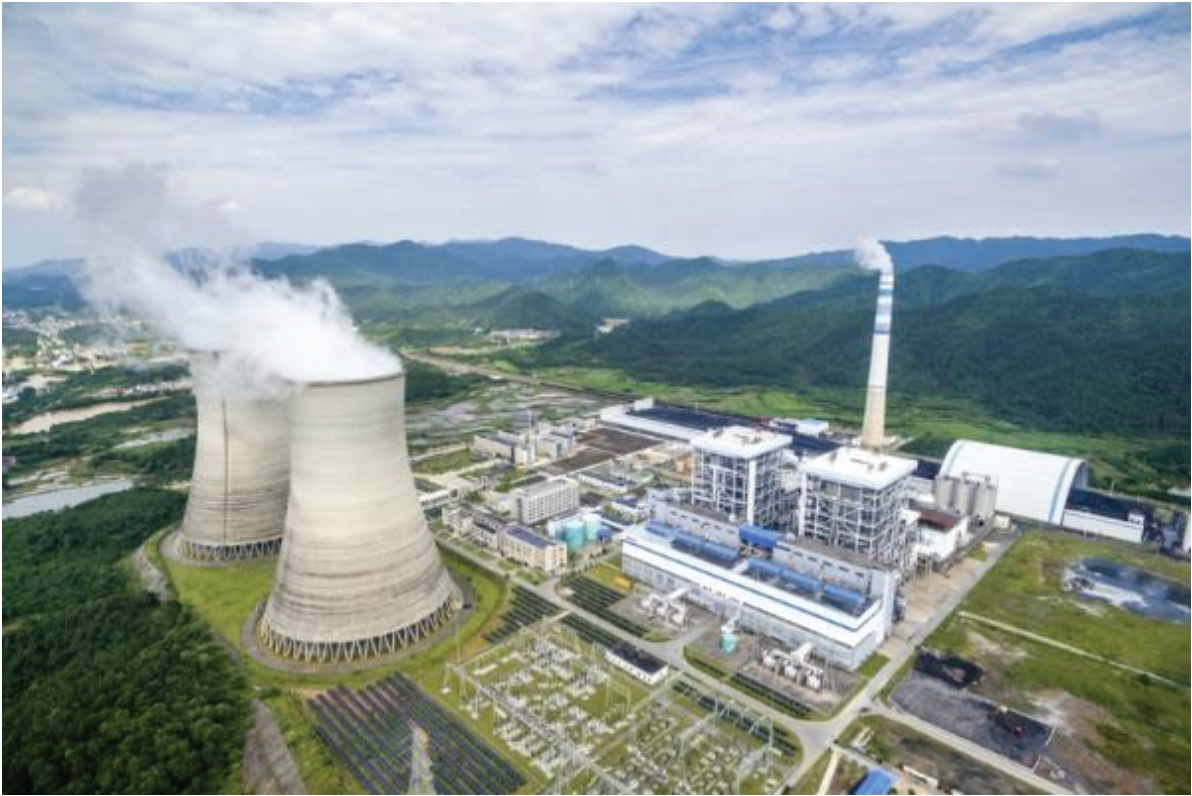
រូបភាពទី១៩. រោងចក្រផលិតថាមពលនៅក្នុងខេត្តព្រះសីហនុ ប្រភព: https://www.construction-property.com/150mw-coal-fired-power-plant-in-sihanoukville-nearing-completion/
